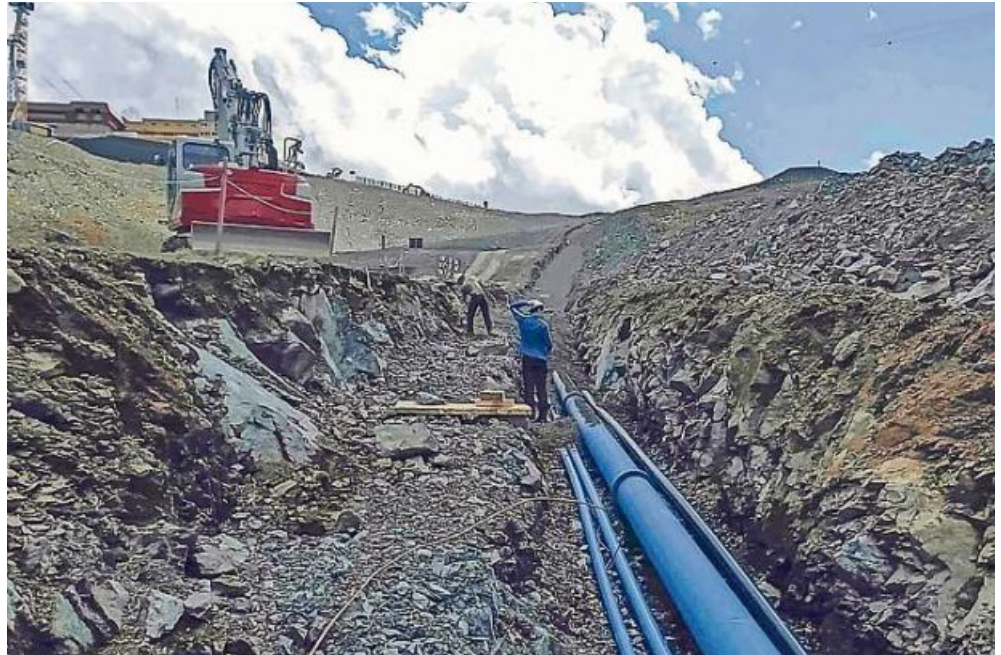
Die meisten Arbeiten sind tief im Boden und werden im Winter nicht mehr zu sehen sein.
