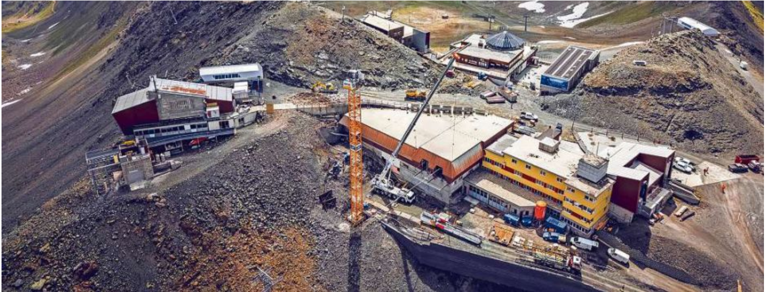
Auf dem Weissfluhjoch geht es vorwärts. Gerade der Kran sticht ins Auge.
