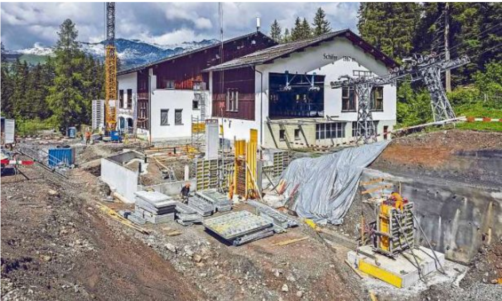
Auch die zukünftige Talstation lässt sich bereits erahnen.
