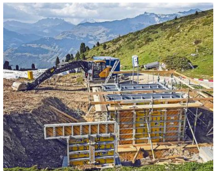
Viele Fundamente für die Stützen sind bereits erstellt.
