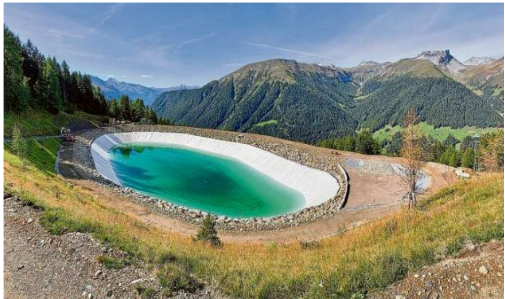
Derzeit wird der neue Speichersee am Rinerhorn mit Wasser gefüllt.
